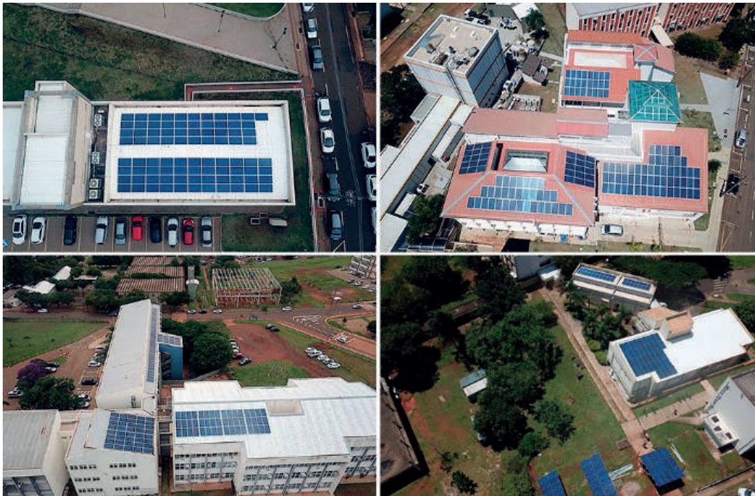
FIGURA 10.10 – PLACAS SOLARES INSTALADAS NO GINÁSIO MULTIDISCIPLINAR E NA FEEC NO CAMPUS DE BARÃO GERALDO
